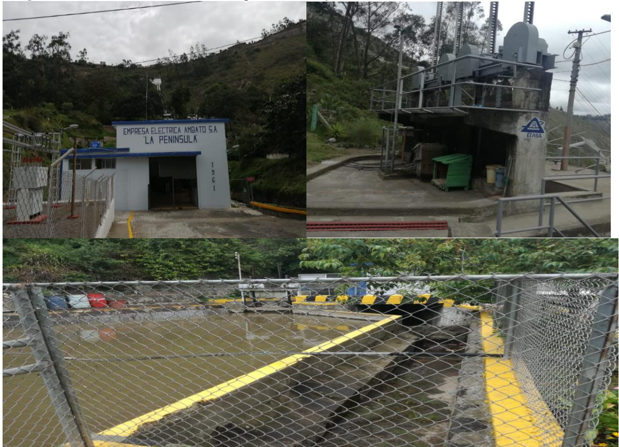
Imagen 13: Subestación La Península, Tanque de Presión y Bocatoma
