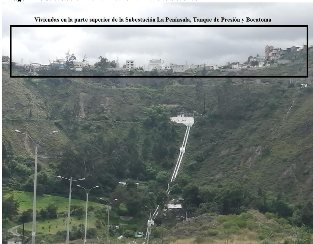
Imagen 17: Subestación La Península – viviendas aledañas.
