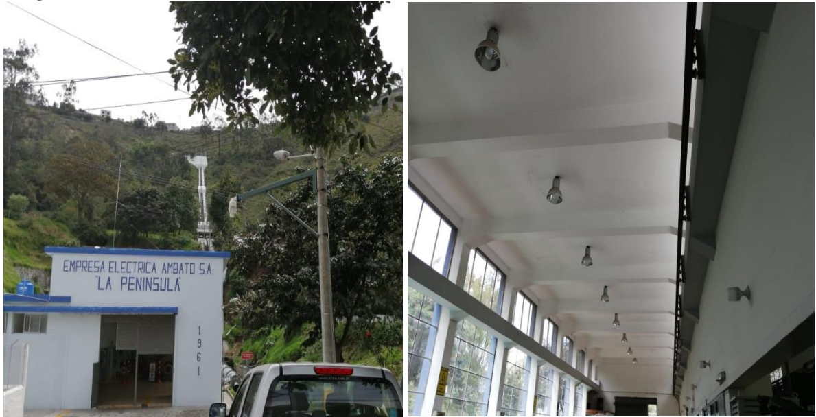
Imagen 16: Subestación La Península, Techo de las Centrales de Generación
