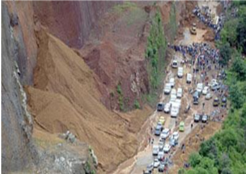
Imagen 2: Deslizamiento de Tierra
