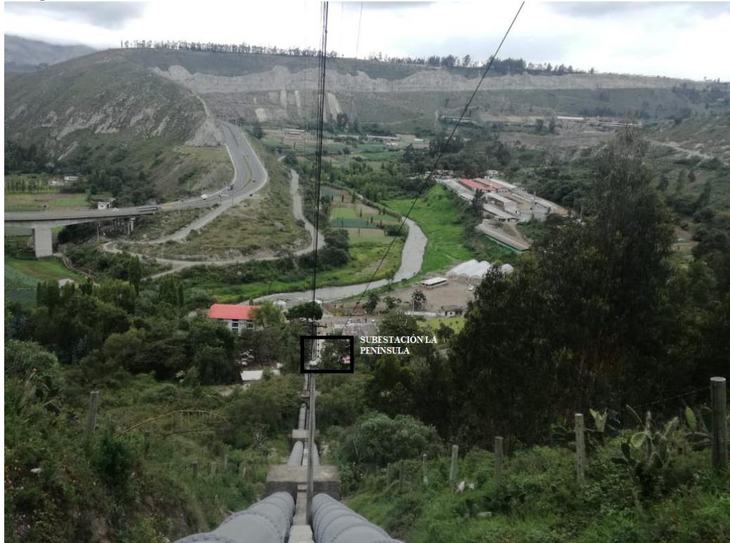
Imagen 15: Subestación La Península
