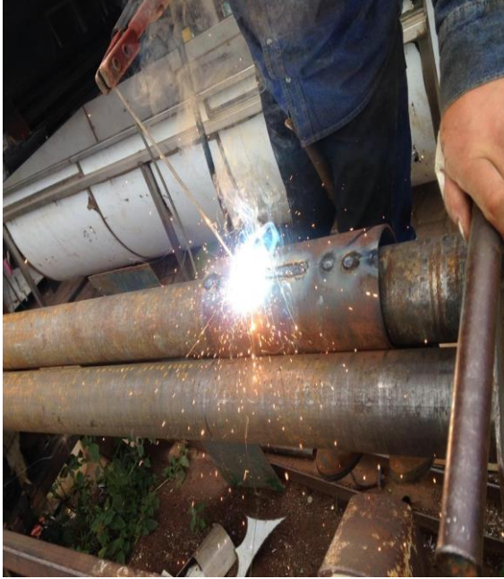
Soldadura del cañón
