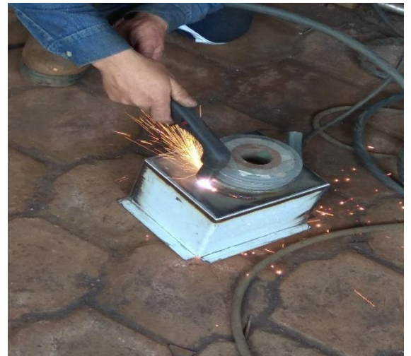
Corte de la recamara para acoplar con el ventilador de aire forzado
