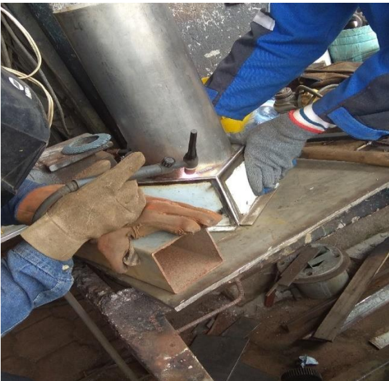
Soldadura del cañón exterior con la recamara
