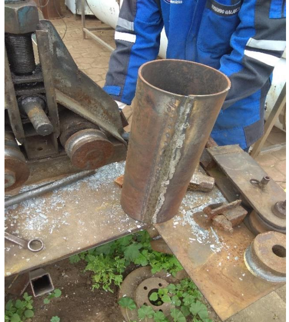
Desbastado de las rebabas de la suelda del cañón
