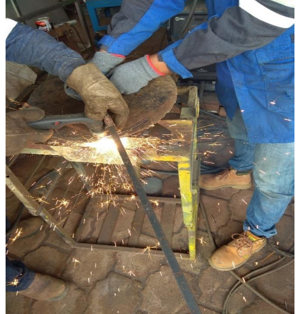
Corte de la brida con plasma
