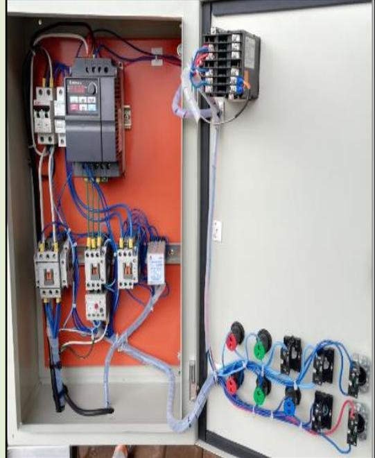
**Ensamblaje del tablero eléctrico**
