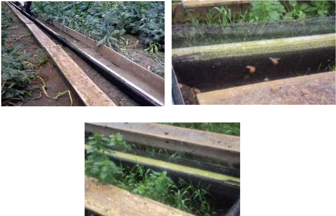
FIGURA N. 34 CONTRUCCION DE LA CERCA ELECTRICA ANTIFUGA
