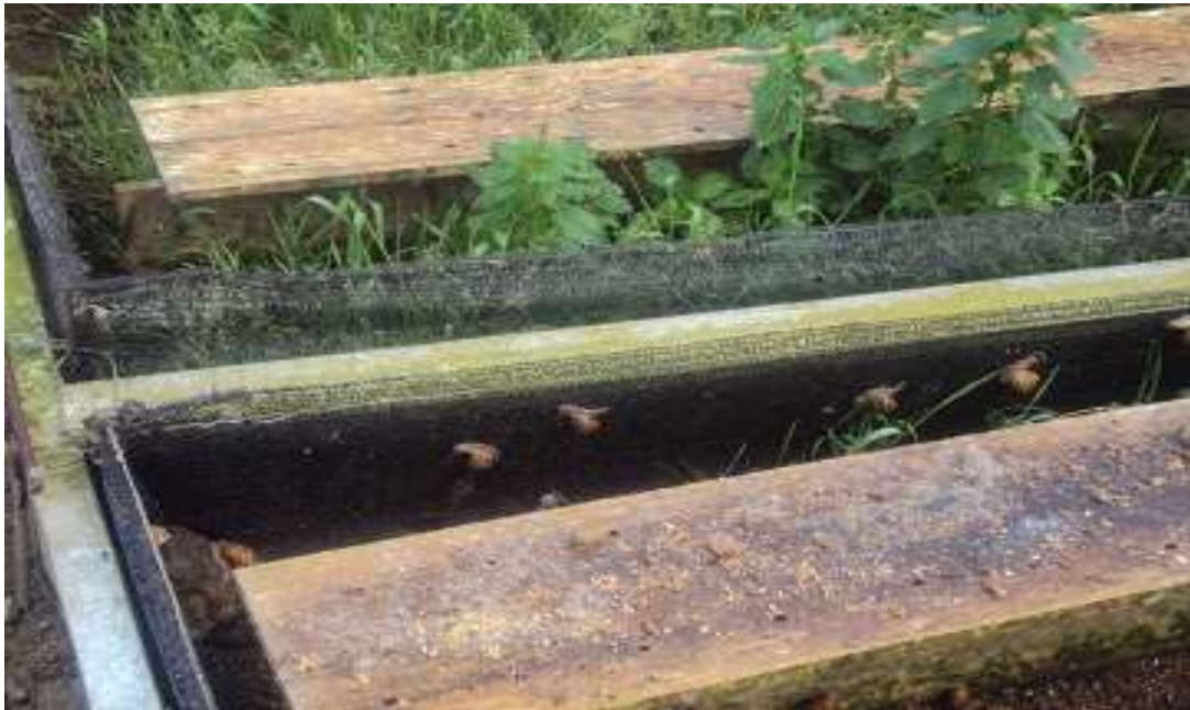
FIGURA N. 35 CONTRUCCION DE LA CERCA ELECTRICA ANTIFUGA
