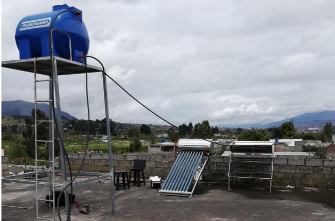
Anexo VI.19.- Pruebas de funcionamiento al sistema ya implementado
