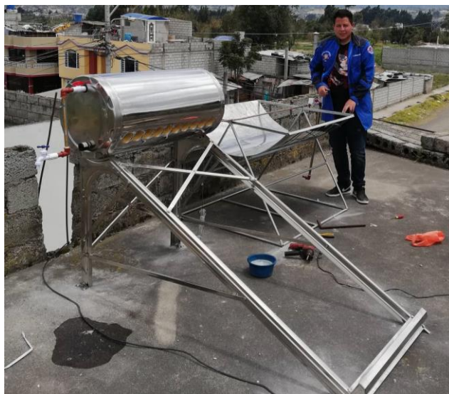
Fig. 1.- Limpieza de zona reflectora
