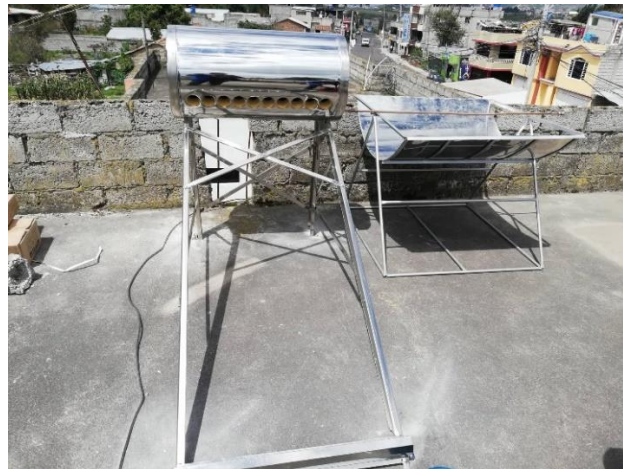
Fig. 3.- Drenado del termo tanque para su limpieza
