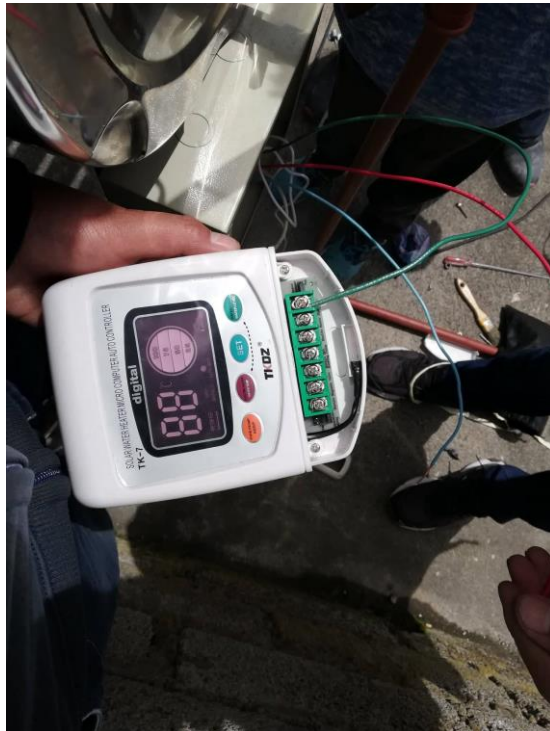
Fig. 8.- Verificación del estado de conductores
