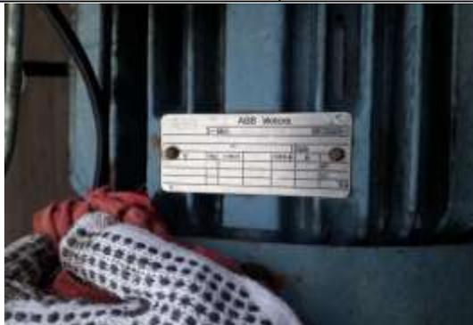
**Figura 4.4** Motor de 5 hp utilizada en la banda transportadora para chispa.
