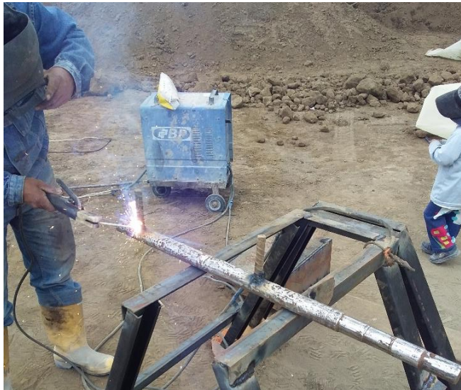
Figura 13. Proceso de soldadura a elementos del tornillo
