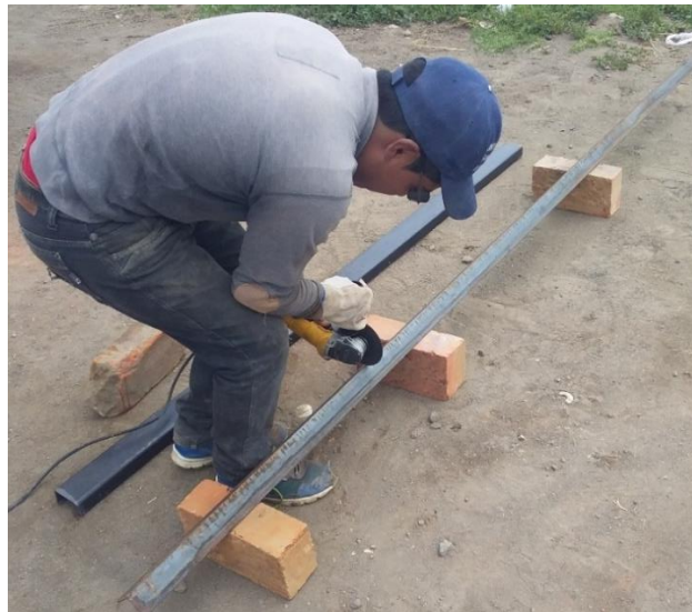
Figura 7. Corte de los perfiles para la estructura
