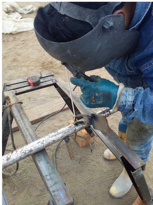
Figura 14. Construcción del filete
