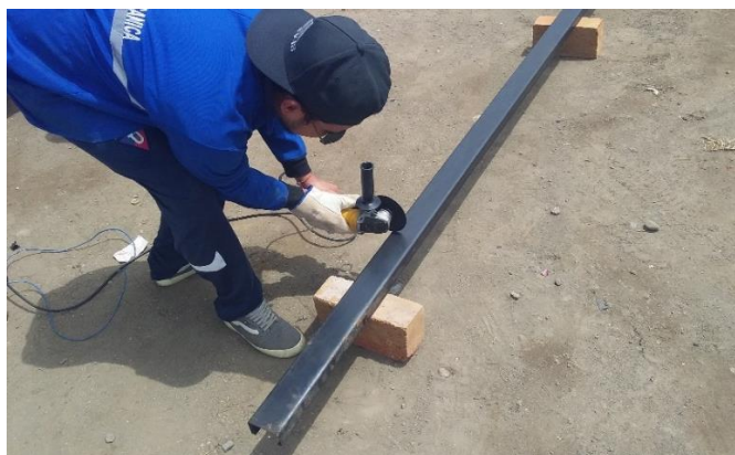
Figura 5. Corte de las correas para la estructura
