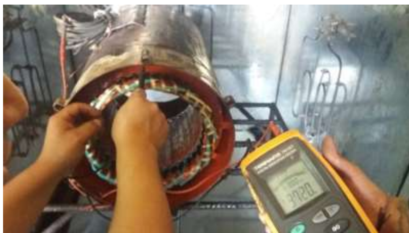
Figura 9. Comprobación de la resistencia del aislamiento mediante el Megger.
