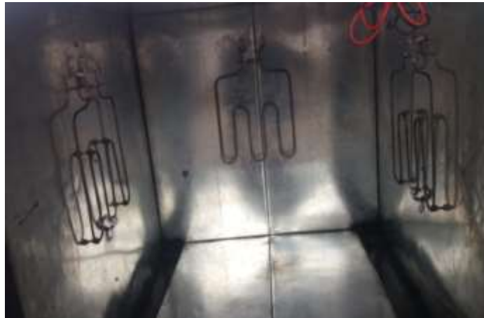
Figura 6. Instalación de las resistencias eléctricas.
