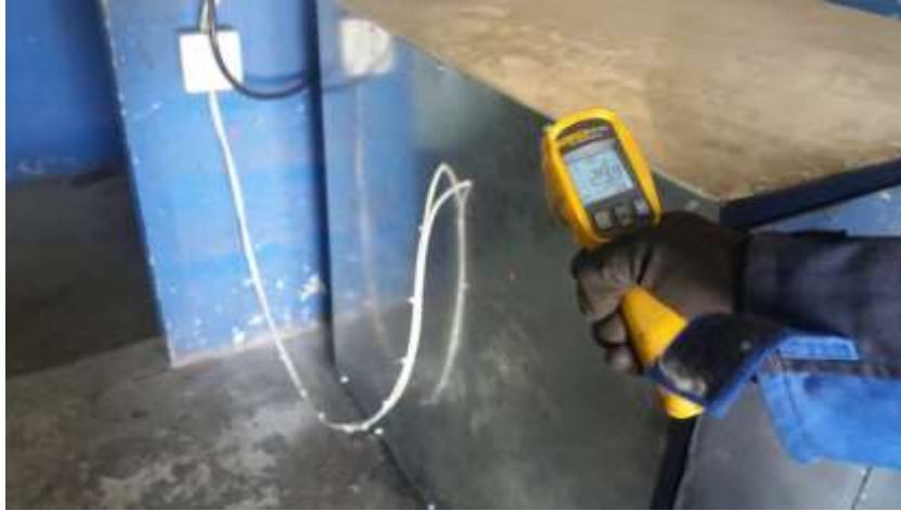
Figura 4. Verificación de la temperatura en la parte exterior del horno.
