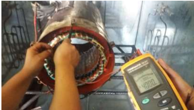
Figura 8. Comprobación de la resistencia del aislamiento mediante el Megger.
