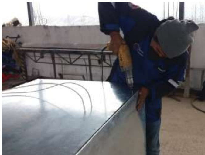
Figura 7. Instalación y reforzado de las cubiertas exteriores del horno.
