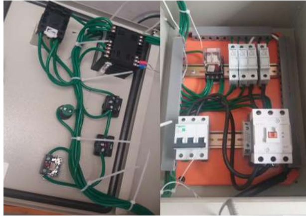
Figura 10. Elaboración de los circuitos de control y fuerza del horno.
