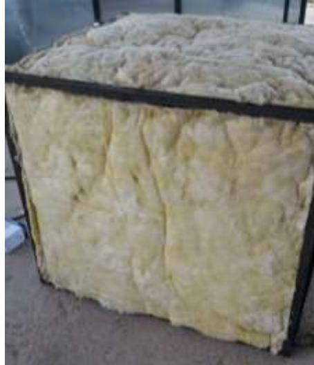
Figura 4. Colocación del aislante térmico.
