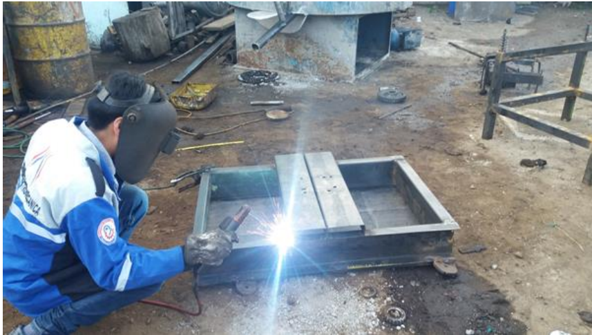
Figura XVI.1. (Soldadura de la bandeja del equipo tamizador)
