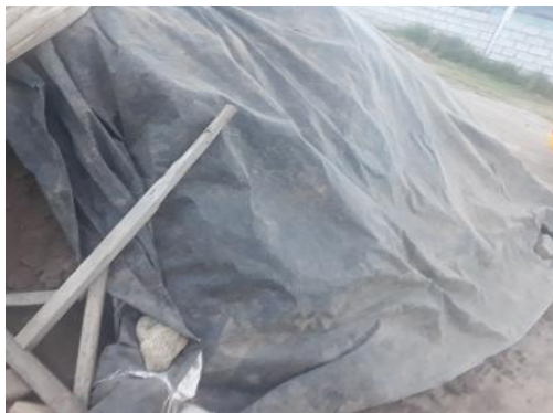
Figura 13: Cubrimiento de la arcilla.
