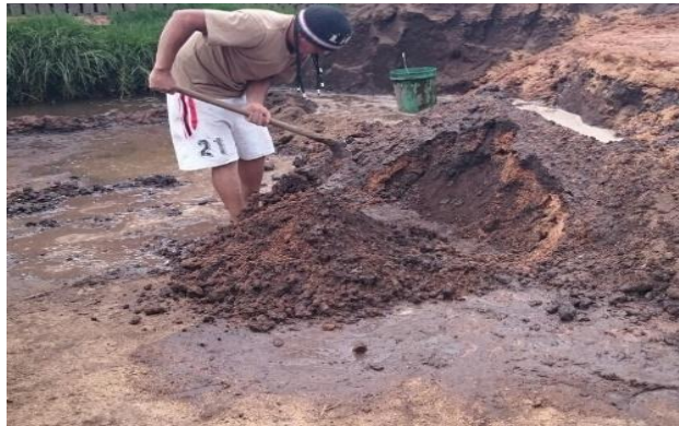
Figura 2: Mezclado del barro
