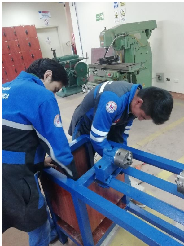
Figura VII.4. Instalación de componentes internos de la máquina de torsión
