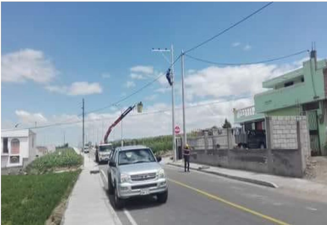
Fotografía N° 3: Instalación de líneas de baja tensión
