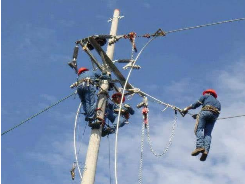
Fotografía N° 3: Instalación de líneas de baja tensión
