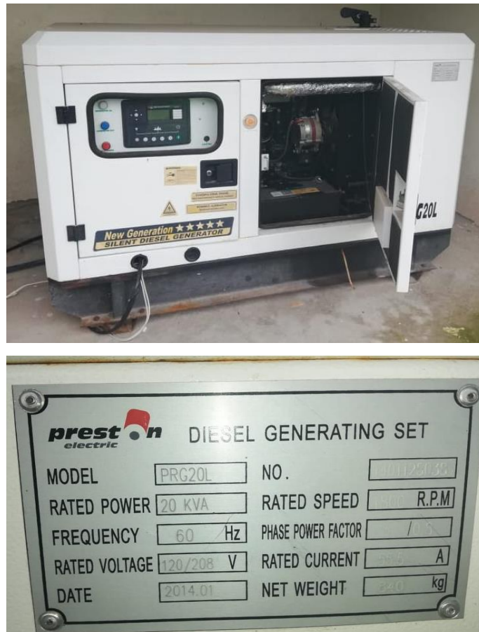
Ilustración 19: Generador Eléctrico prest.n
