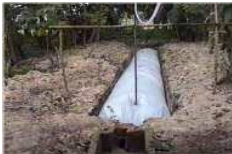
Ilustración 4: Biodigestor de globo
