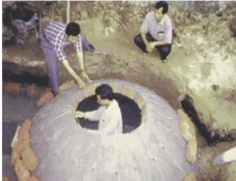
Ilustración 6: Biodigestor fijo en construcción.
