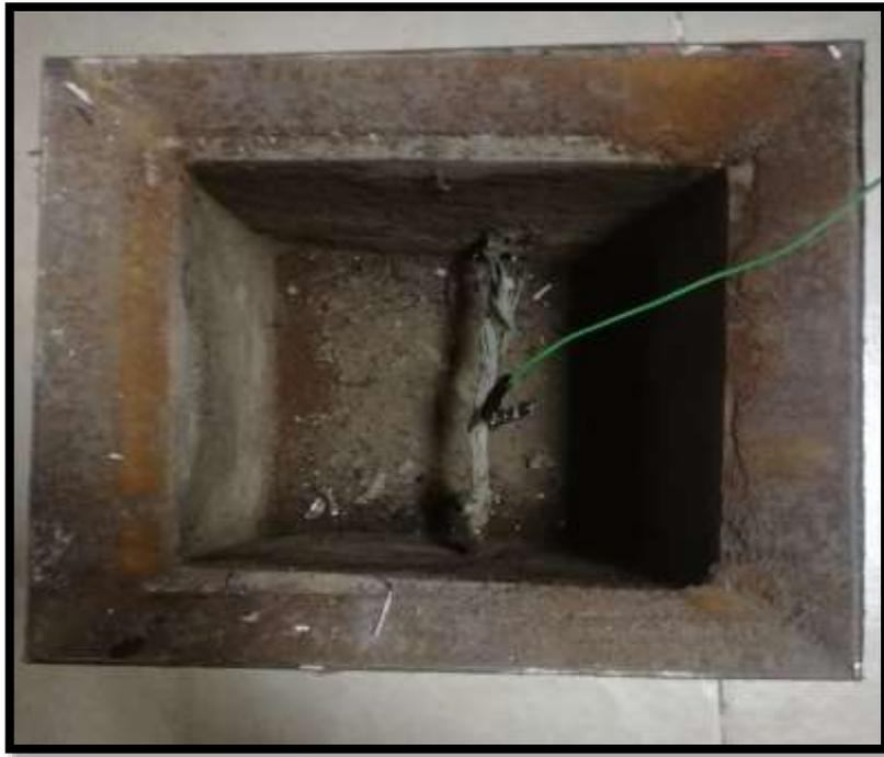
**Figura 8.** Conexión a tierra del laboratorio.
