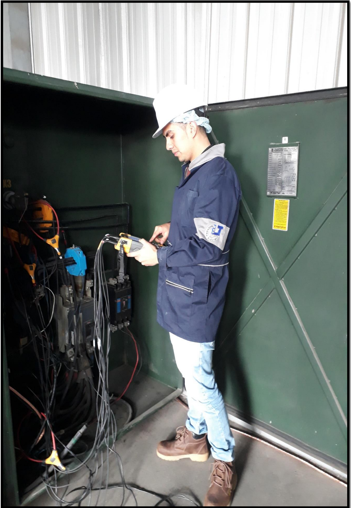
Figura I.XI: Instalación equipo fluke 435 ii
