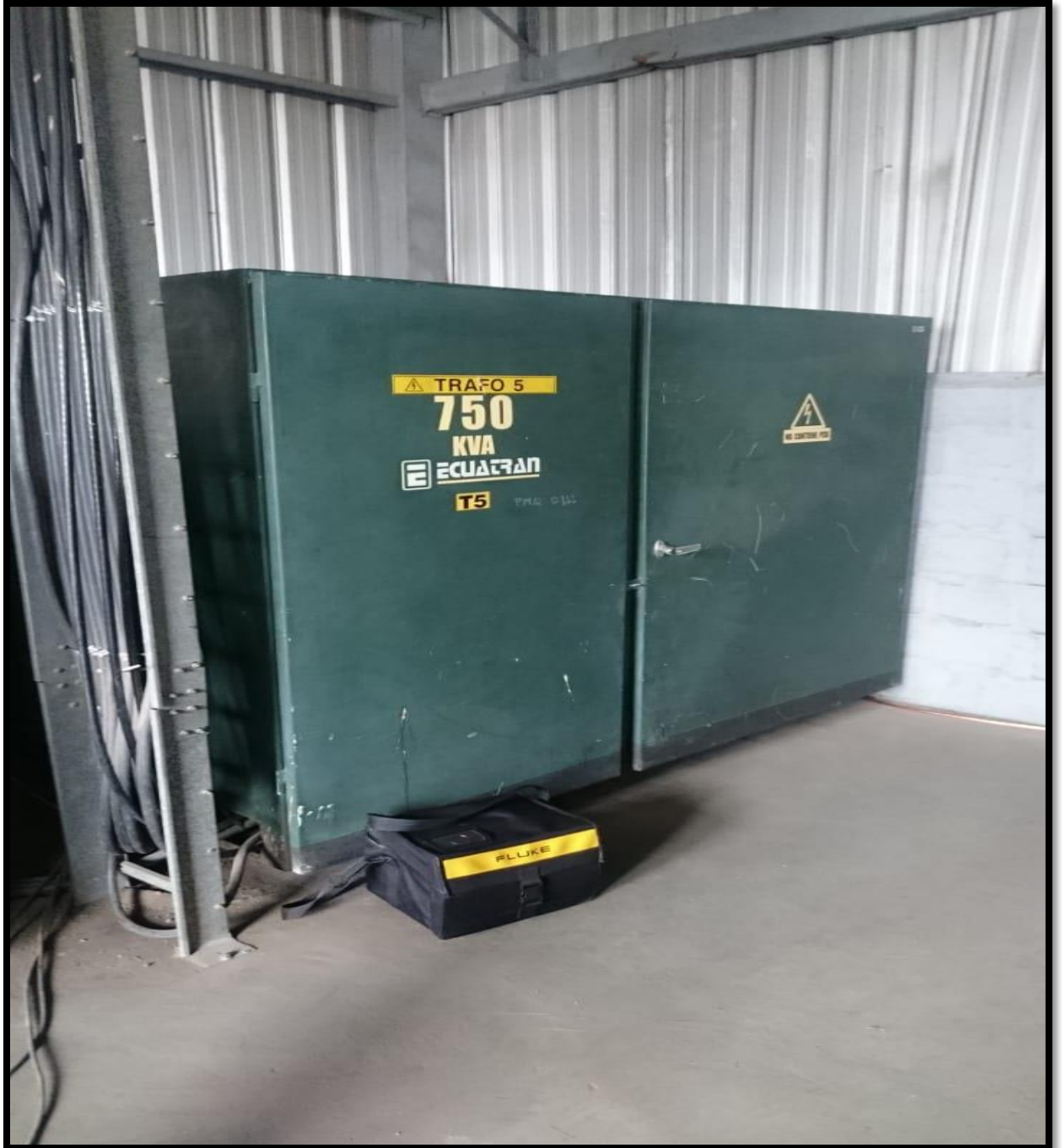
Figura I.I: Transformador trifásico de 750 kVA
