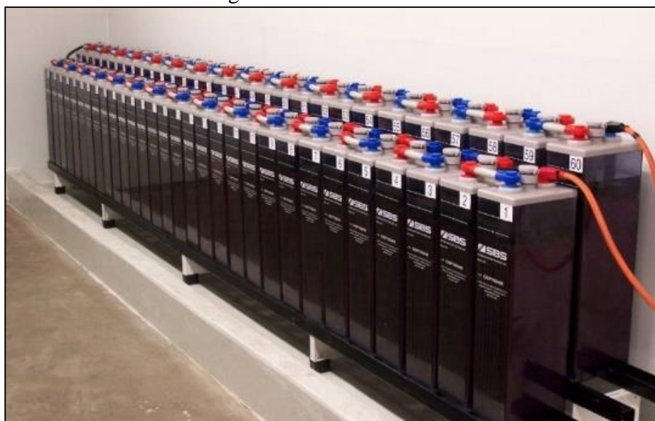
Figura A43. Baterías de ion-litio.
