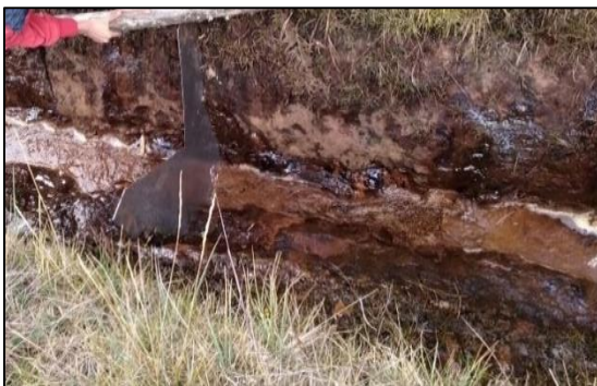
Figura 3. Vertedero de 90° instalado en la sequía número 1.
