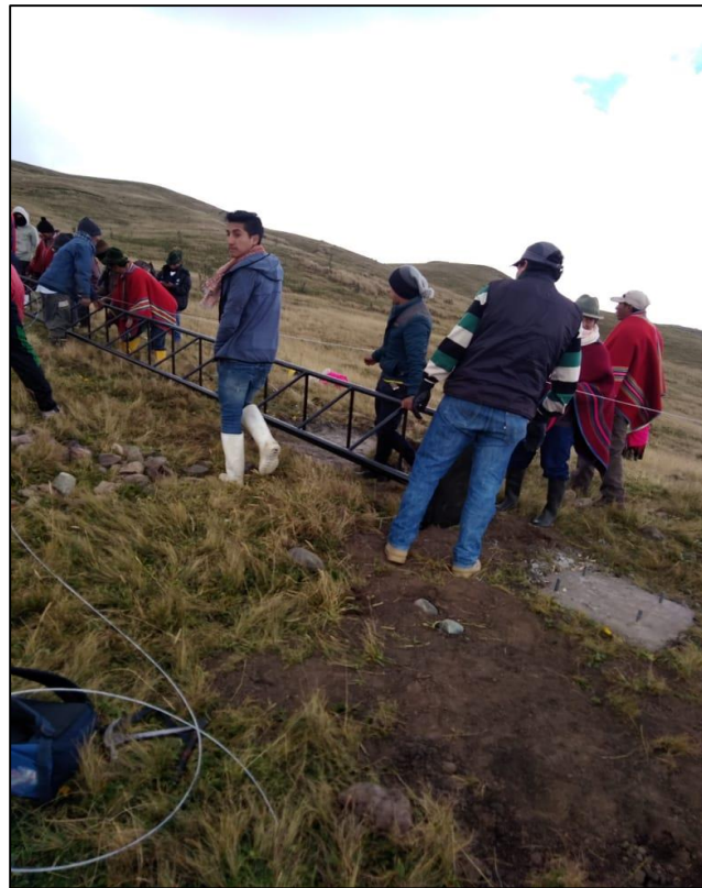
Figura A35. Minga para colocación de torre en lugar de estudio
