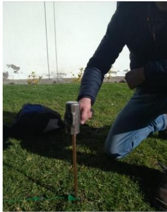
**Ilustración 11.21.** Electrodo cooperweld para malla.
