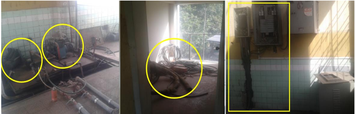
Imagen 10: Área de máquinas, Área de Bodega, Área de Tableros Eléctricos
