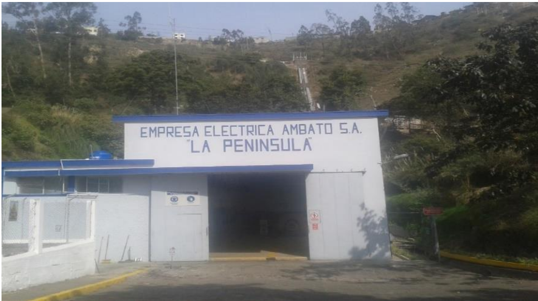
Fuente: Subestación Hidráulica La Península
