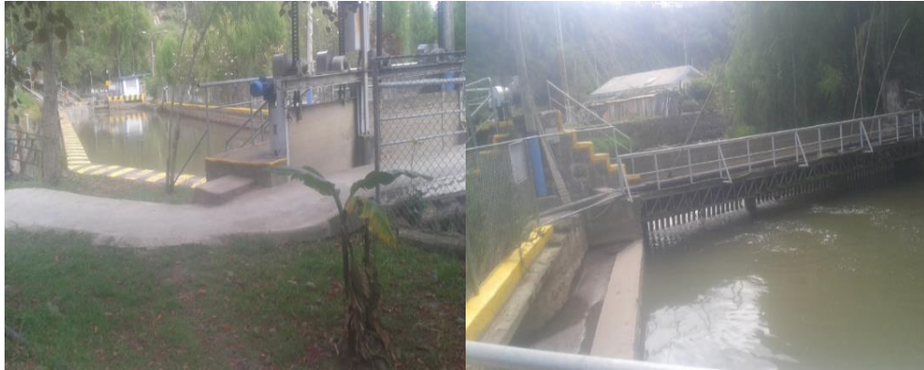
Fuente: Subestación Hidráulica La Península
