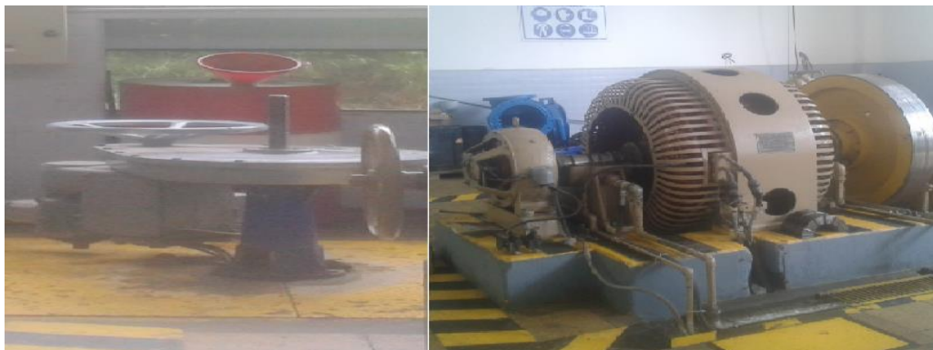
Imagen 23: Área de Turbina del Grupo 1-2 y Grupo 3-4
