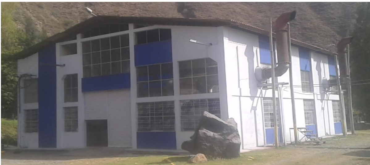
Fuente: Central Térmica Lligua
