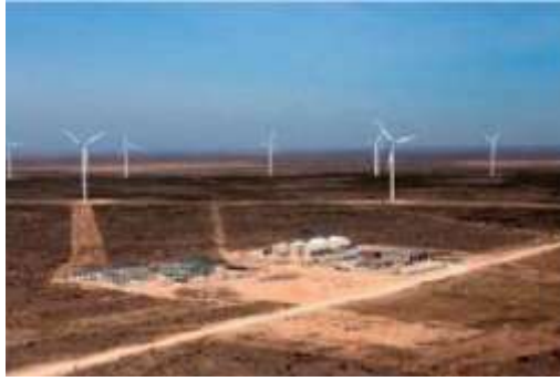
Figura 8. 11.- Parque Eólico Texas 36 MW batería plomo- ácido [4]
