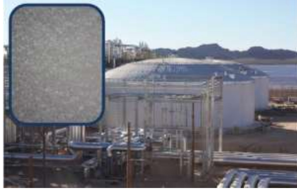
Figura 8. 7.- TES y sus tanques de almacenamiento en Arizona y detalle de sales [19]
