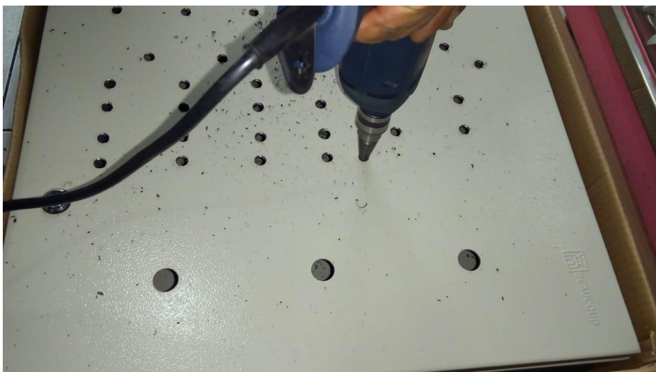
Figura 5.7: Perforación para la instalación de las borneras
