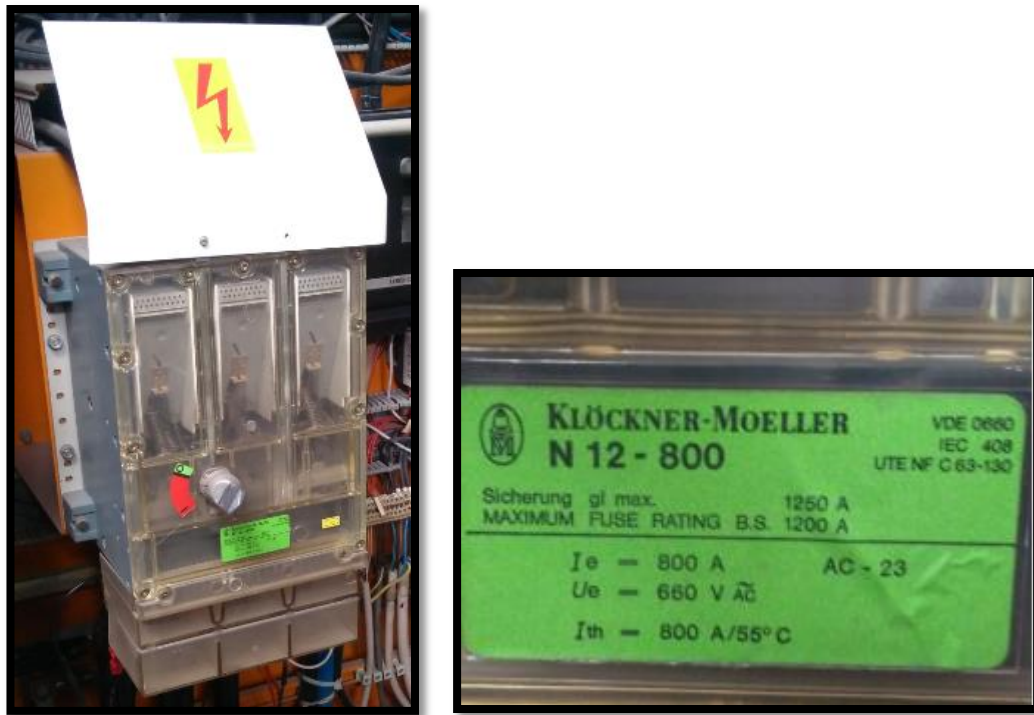
FIGURA 5. 1. Disyuntor termo magnético principal y datos de placa
