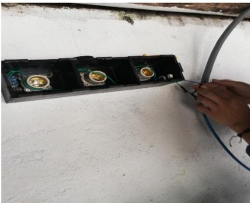
**Fotografía C.11:** Prueba de las entradas de los relés
