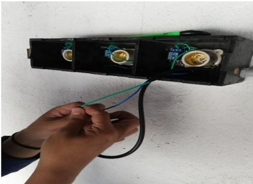
**Fotografía C.9:** Conexión de los módulos Relé
