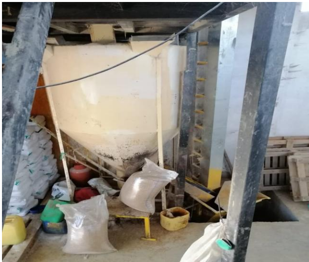
Figura 7 Proceso de Balanceado Fuente: “CAVICENTE” Cía. Ltda
