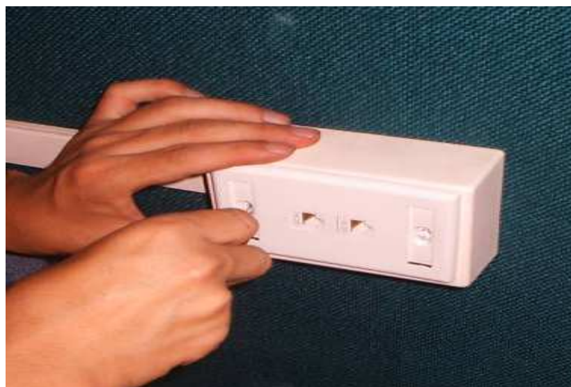
Figura 4.14. Colocación de los Face Plate.
