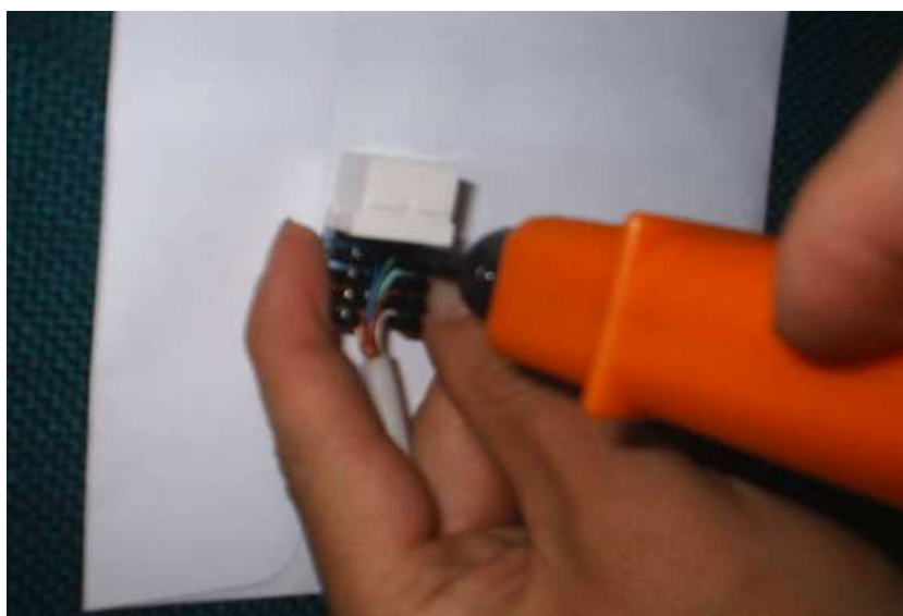
Figura 4.12. Inserción del Cable UTP en los Jacks.
