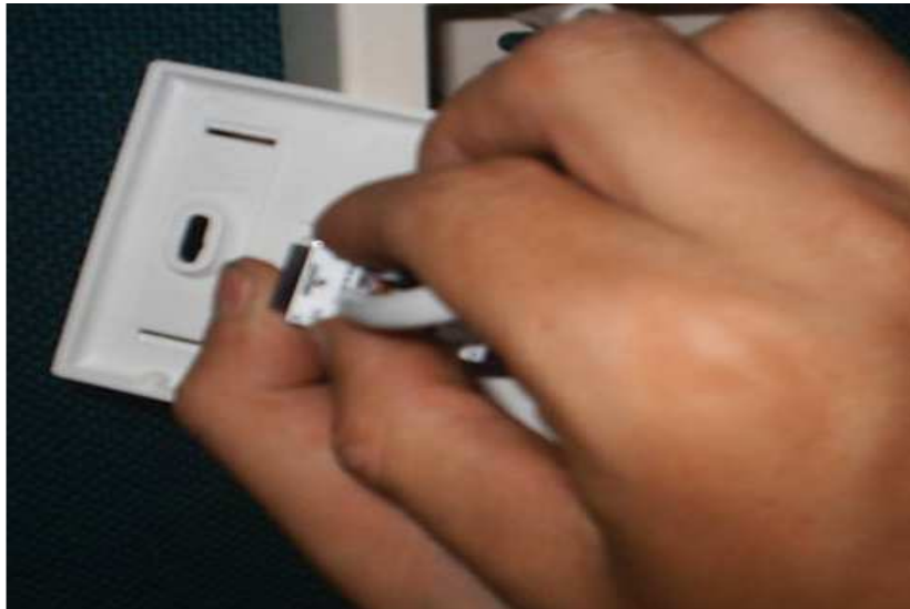
Figura 4.13. Inserción de los Jacks en los Face Plate.
