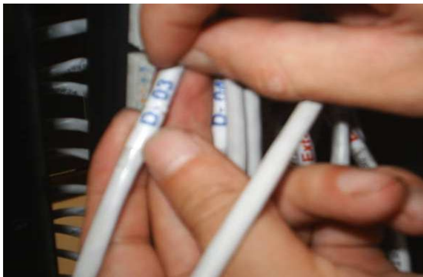
Figura 4.11. Etiquetado del Cable al Patch Panel
