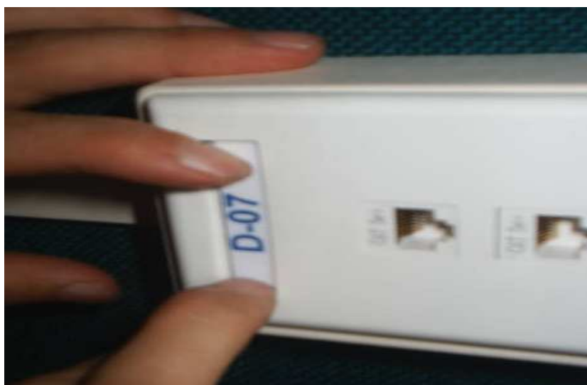
Figura 4.15. Etiquetado de los Puntos de Red.
