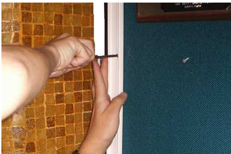
Figura 4.1. Colocación de Canaletas
