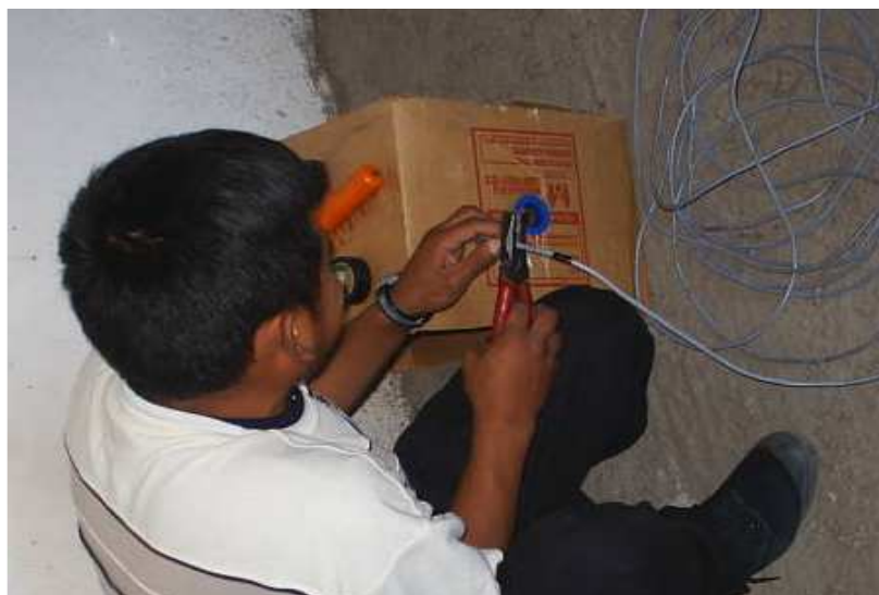
Figura 4.5. Cortado de Cable UTP
