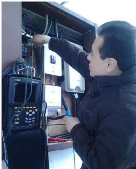
Figura 3.5. Instalación del analizador de redes.
