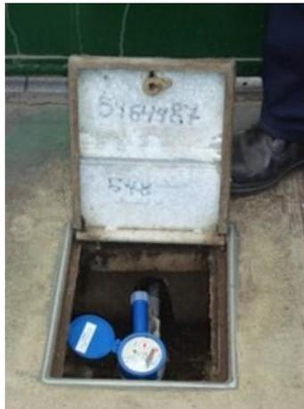
Figura 3.2. Medición del consumo de agua con medidor de flujo general del Edificio.
