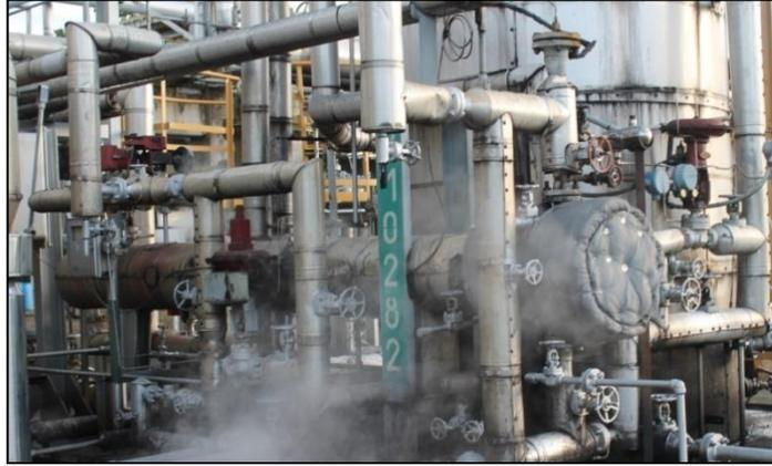
Figura 4.4. Intercambiador de calor del sistema de combustible.
