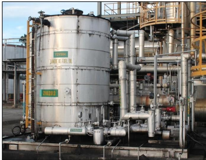
Figura 4.3. Tanque de almacenamiento diario de crudo reducido.
