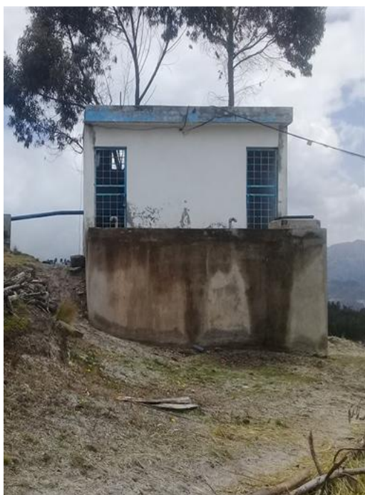
Tanque de almacenamiento
