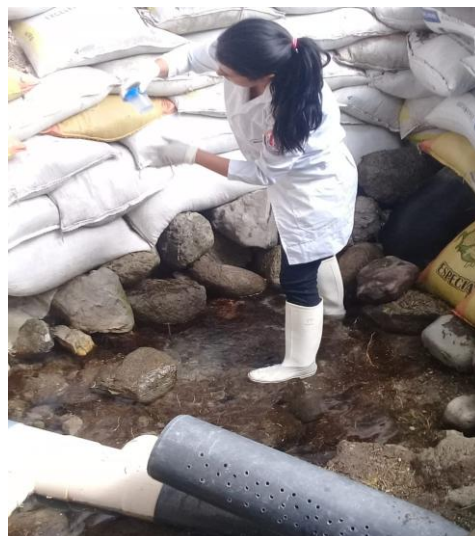
Verificación de burbujas de aire.
