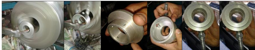
Figura 5.10. Procedimiento de construcción
