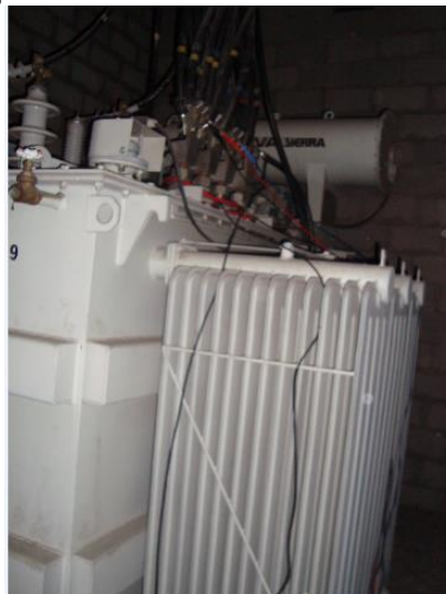
Figura N° 4.15: Transformador MP5
