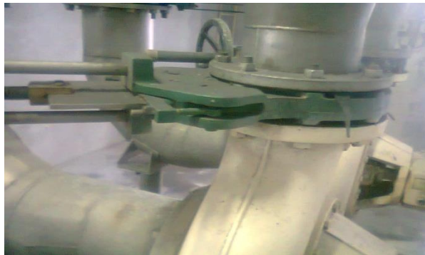
Figura N° 4.19 Válvula inyector PPP5
