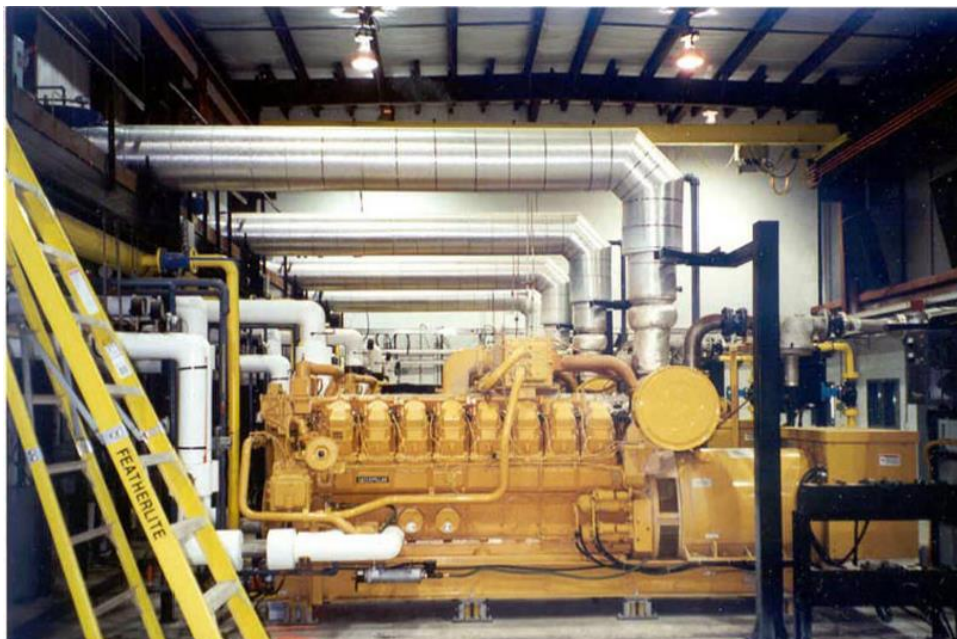
Figura 2. 4 Sistema modular de conversión de gas de invernadero en energía eléctrica (Highland Energy Inc)
