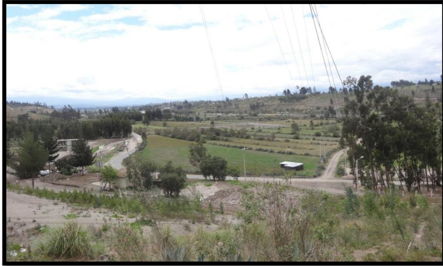
Figura 3. 4 Entrada al botadero de cielo abierto de EPAGAL Fuente: Iván Oswaldo Mena Venegas
