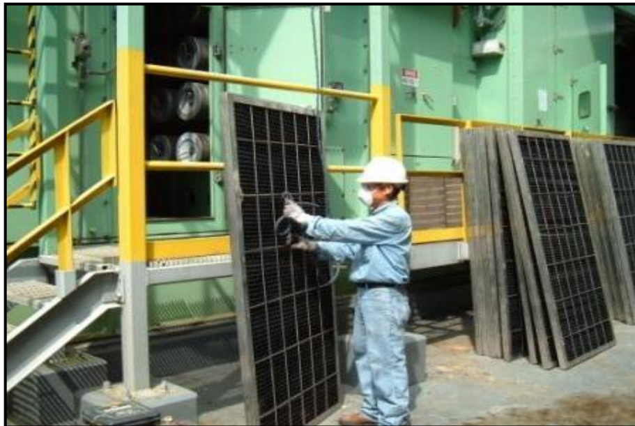
Fuente: Turbina TR-117A, Repsol 2015
