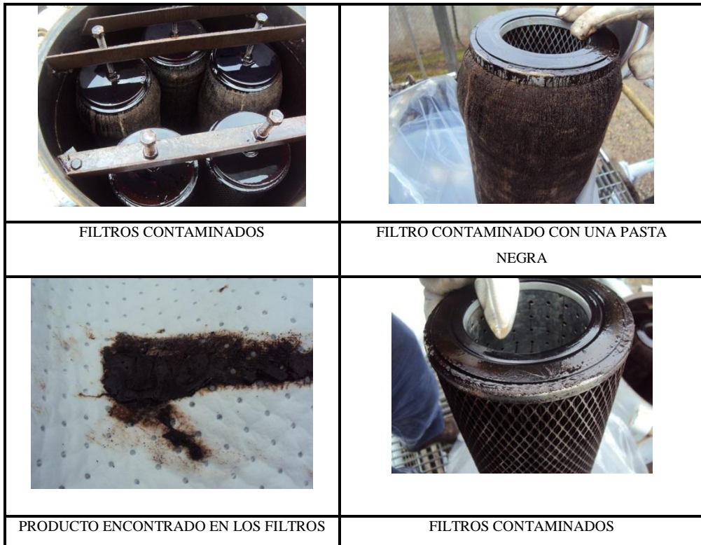
Figura 3.35 Filtros de diésel contaminados
