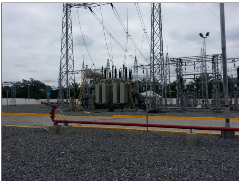
Gráfico N° 4. 12: Ensamblaje del sistema contra incendios.
