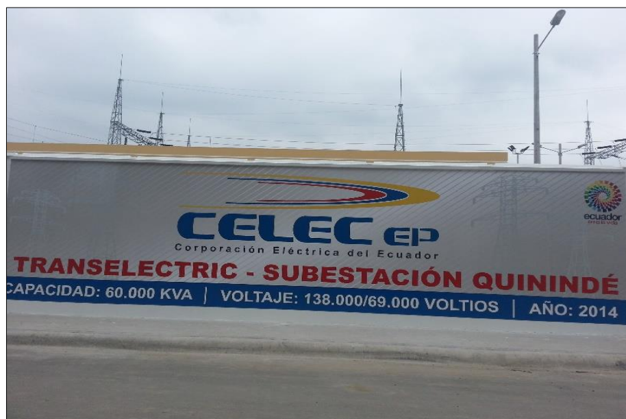
Gráfico N° 4. 1: Subestación Eléctrica Quinindé. Fuente: Subestación Quinindé – CELEC EP, 2015.
