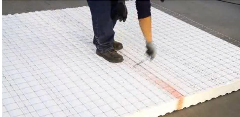
Gráfico 52: Armado de pared tipo sanduche
