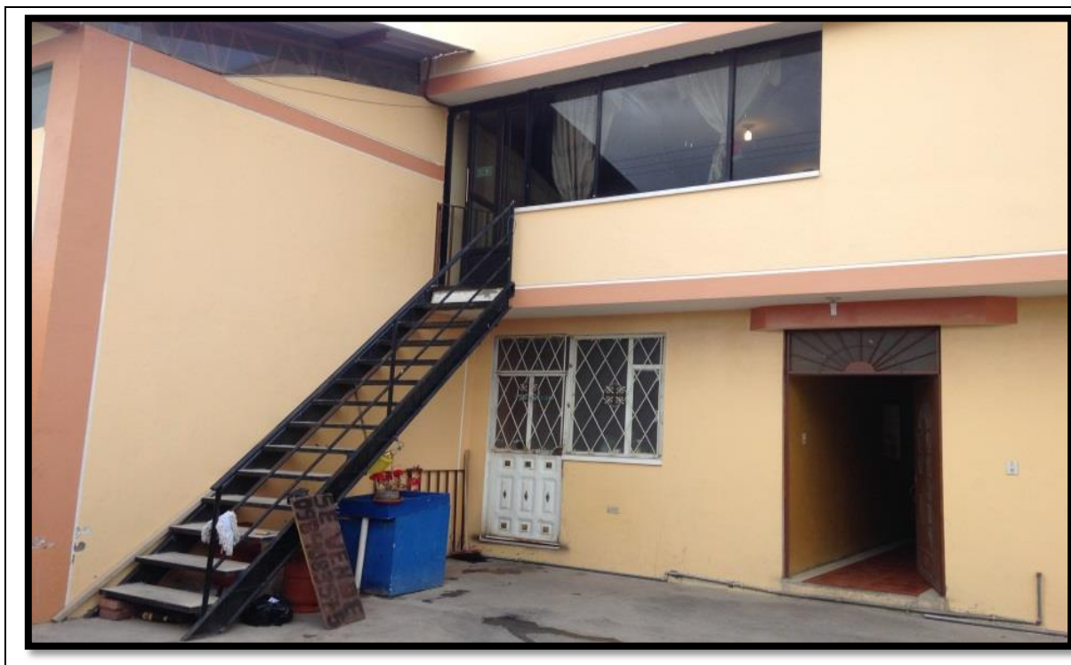
Fotografía 2: Instalación interna de la empresa “Don Jorge”.
