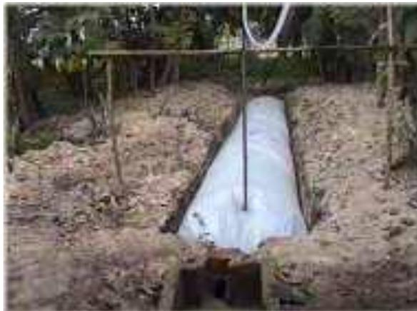
**Figura No. 4 Biodigestor de flujo pistón horizontal**
