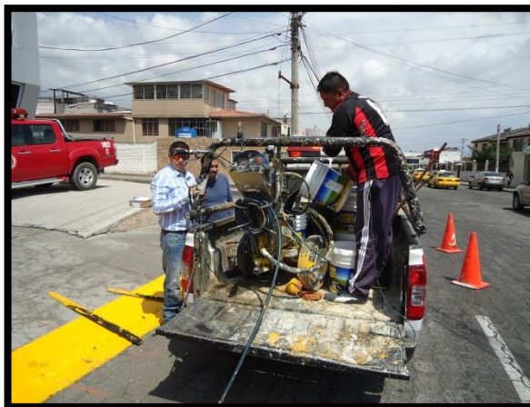
Foto N°2: PREPARACIÓN DE PINTURA DE ALTO TRÁFICO EN CAMPO
