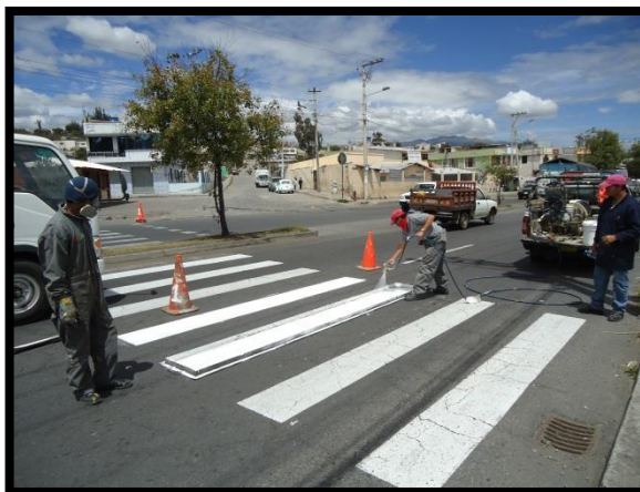
Foto N°3: PINTURA DE ALTO TRÁFICO
