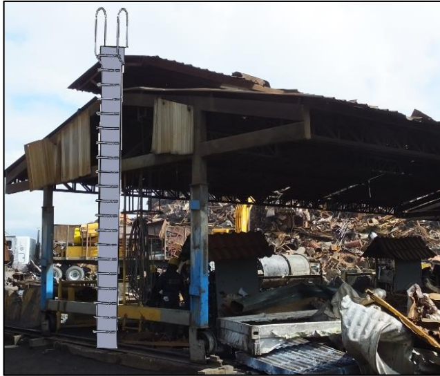
Gráfico N° 18: Escalera vertical integrada en las naves – Naves de corte Fuente: Propia
