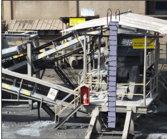
Gráfico N° 19: Escalera vertical integrada en estructura – Trituradora de escoria Fuente: Propia
