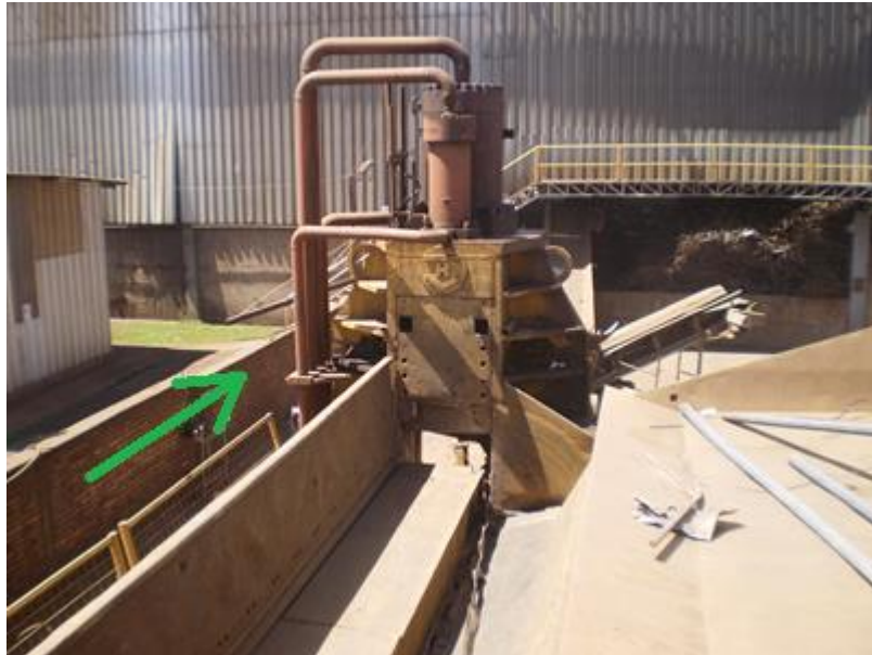
Gráfico N° 20: Vía de acceso a los cilindros hidráulicos – Prensa cizalla Fuente: Propia
