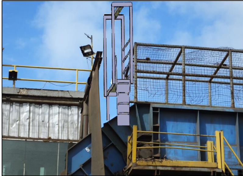
Gráfico N° 22: Estructura de seguridad para la zona de cortinas de seguridad - Fragmentadora Fuente: Propia
