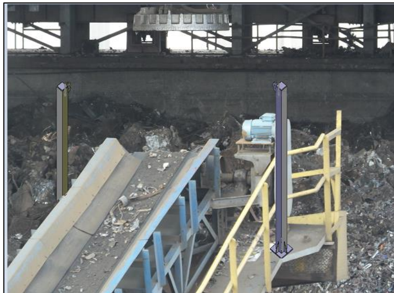
Gráfico N° 3: Puntos de anclaje en la zona de caída de chatarra triturada Fuente: Propia
