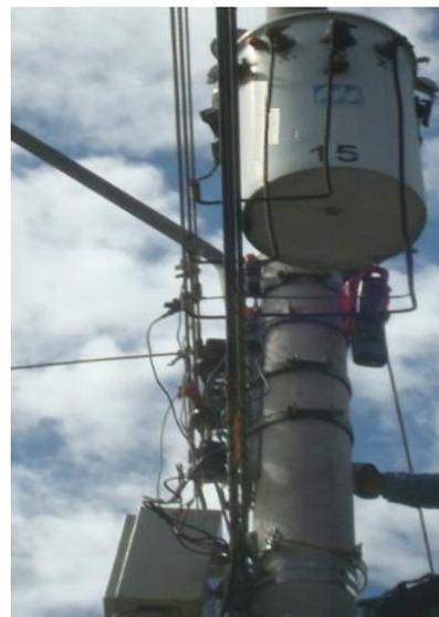
**Gráfico No. 16: Registro e instalación de analizador de energía**
