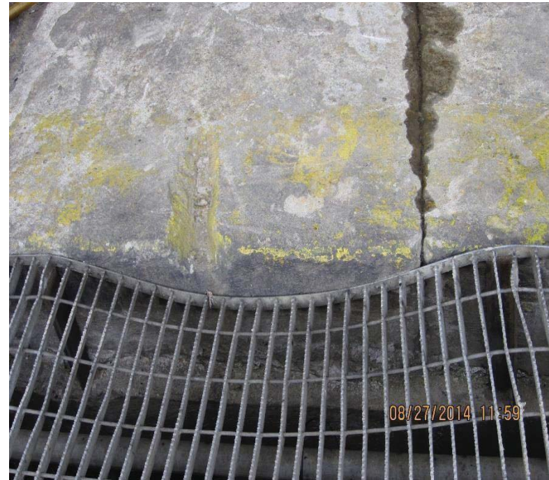
Ilustración 2 Rejilla 1 zona de generadores
