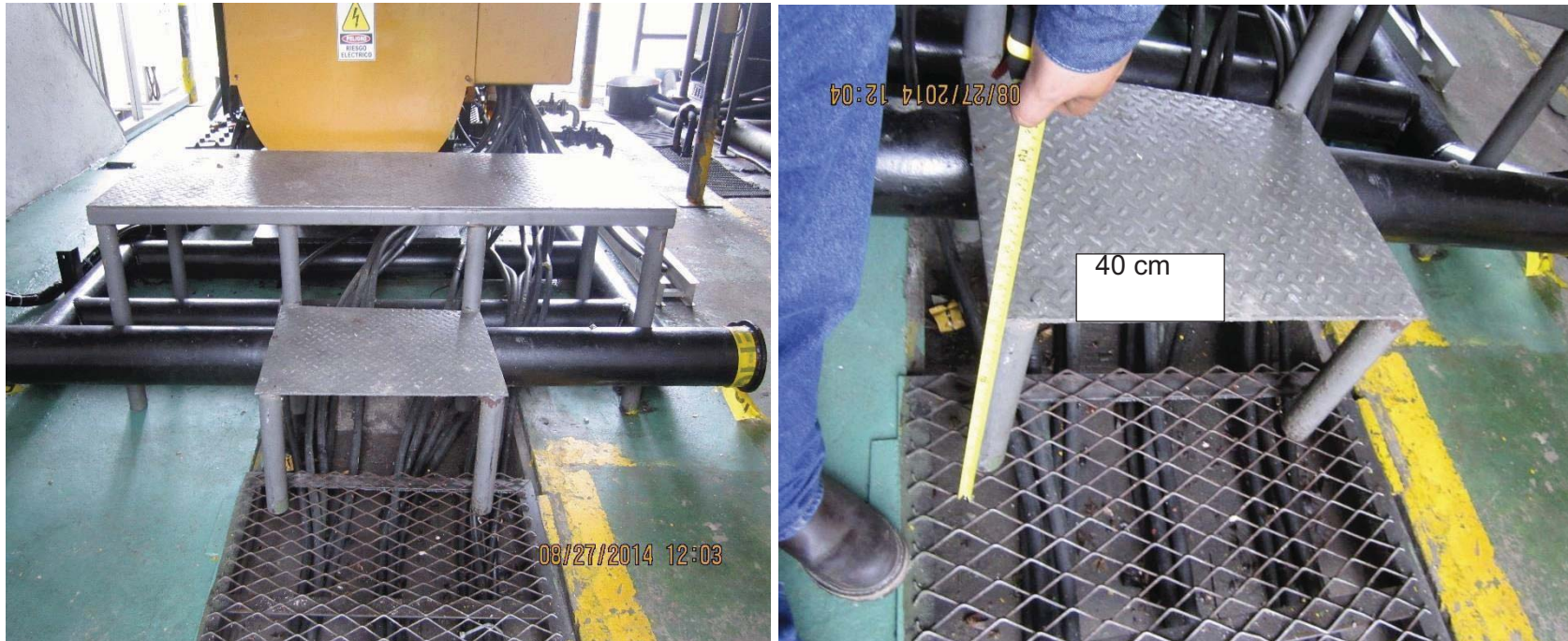
Ilustración 10 Escalones al control de los GENERADORES QUE NO CUMPLEN CON LA NORMATIVA
