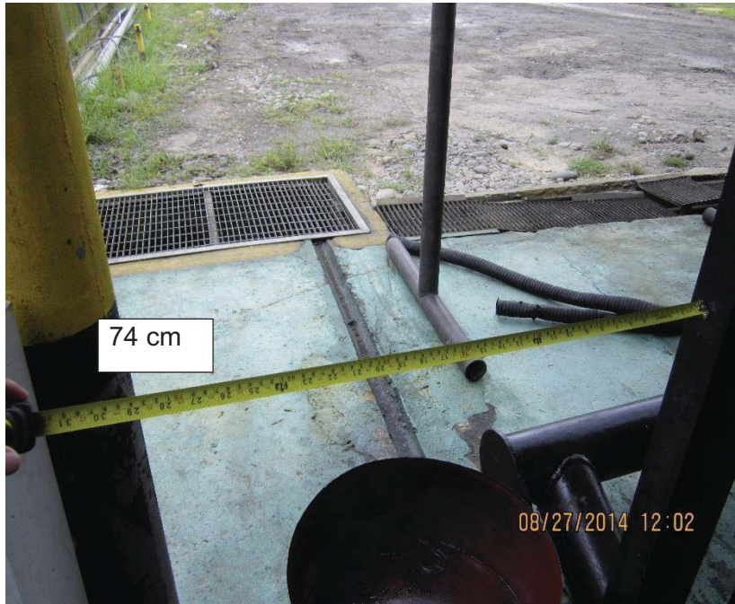
Ilustración 7 ANCHO ENTRE LOS GENERADORES MUY ANGOSTO
