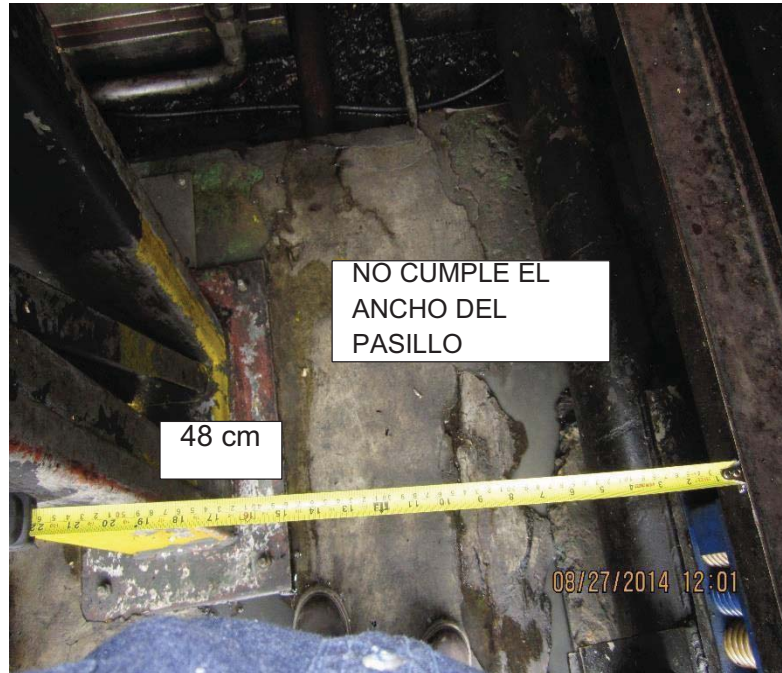
Ilustración 7 ANCHO ENTRE LOS GENERADORES MUY ANGOSTO
