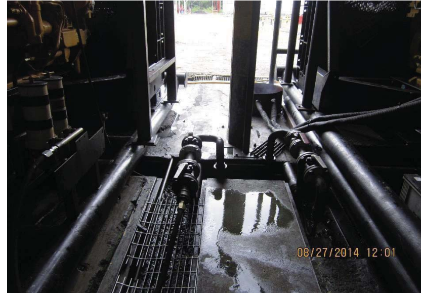
Ilustración 8 ANCHO DE PASILLO INADECUADO Y CHARCO EN EL PISO
