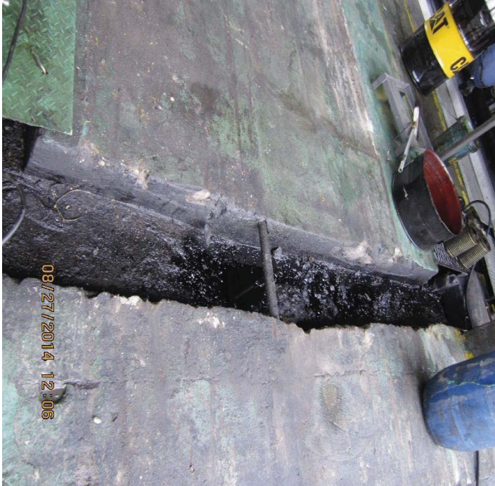
Ilustración 13 HUECOS SIN PROTECCION DE PASO
