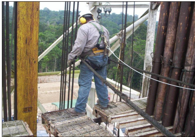
Figura 2.3 Manejo de tubería en torre de perforación
