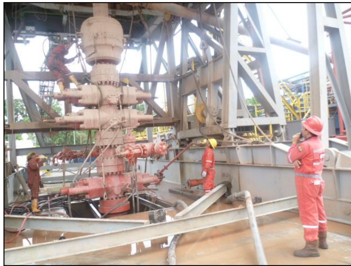
Figura 2.7 Supervisión de actividades de perforación y mantenimiento
