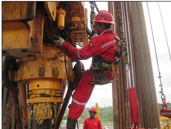
Figura 2.8 Mantenimiento de equipos de perforación (Top Drive)
