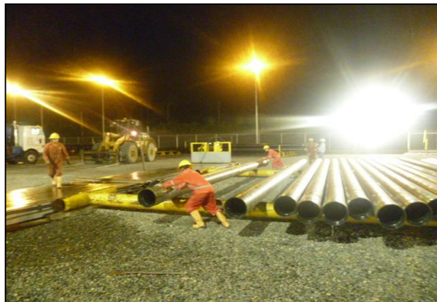
Figura 2.1 Patio de maniobras (Manejo de tubería)
