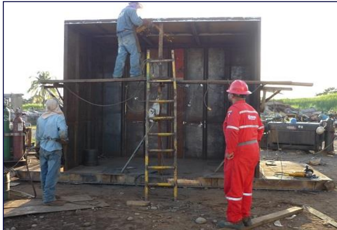
Figura 2.12 Supervisión de trabajos de soldadura
