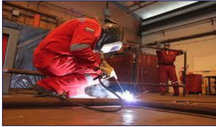
Figura 2.13 Trabajo de soldadura
