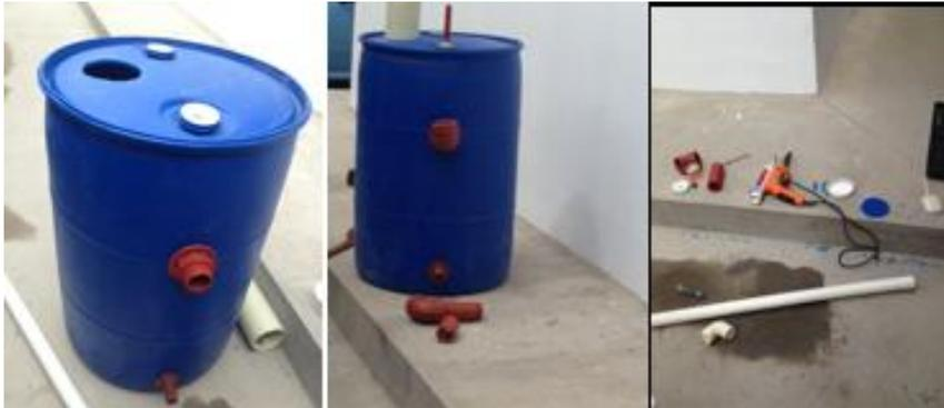
**Figura No. 7 Construcción del biodigestor**
