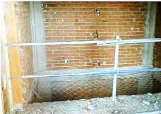
Ilustración 20: Desniveles y orificios 1 Imagen: www.lineaprevencion.com
