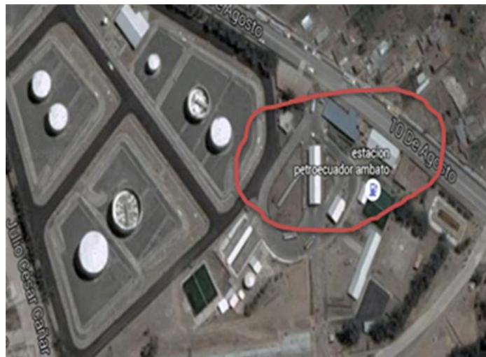
Figura 1-1. Describe la ubicación geográfica de la Estación Reductora Poliducto Quito – Ambato – Riobamba, obtenida de la fuente de Google Maps.
