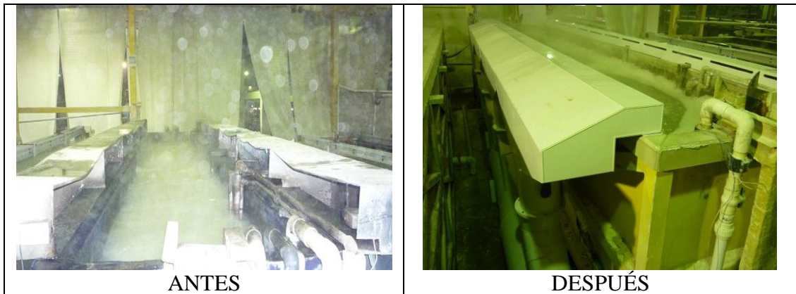
Figura 39. Sistema de extracción en el área de Anodizado
