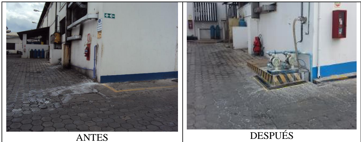
Figura 35. Zona de descarga de soda cáustica del área de Matricería Elaborado por: G. Plaza Fuente: CEDAL, 2015
