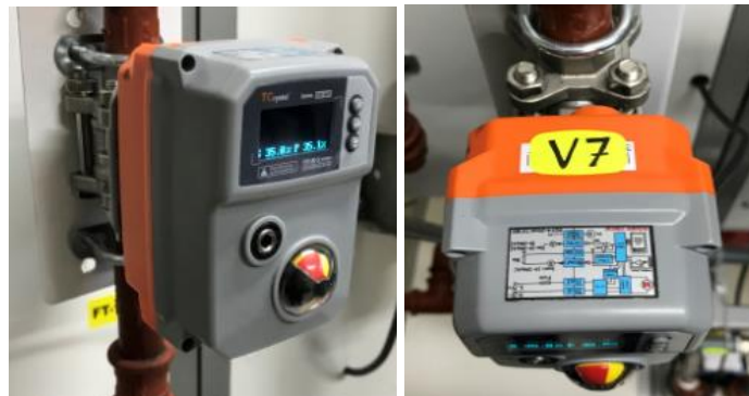
Figura 3.5. Válvula de bola de ½” con actuador TCN-02T
