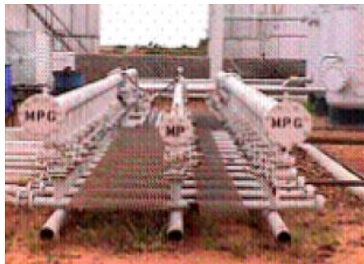
Figura 1.1. Múltiple de producción de una estación de flujo
