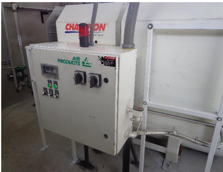
Gráfico 26: Tablero de control del compresor CHAMPION Elaborado por: Raúl Andrago (2015)
