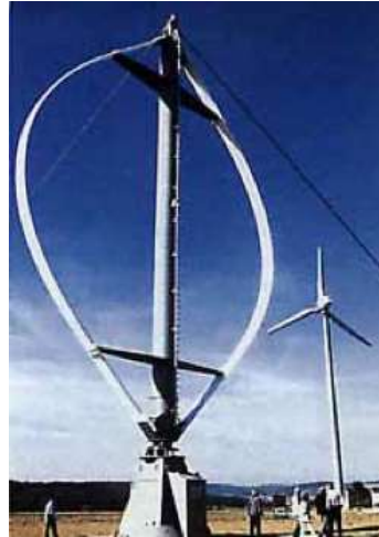
Gráfico No. 1.5. Modelo de aerogenerador Darrieus
