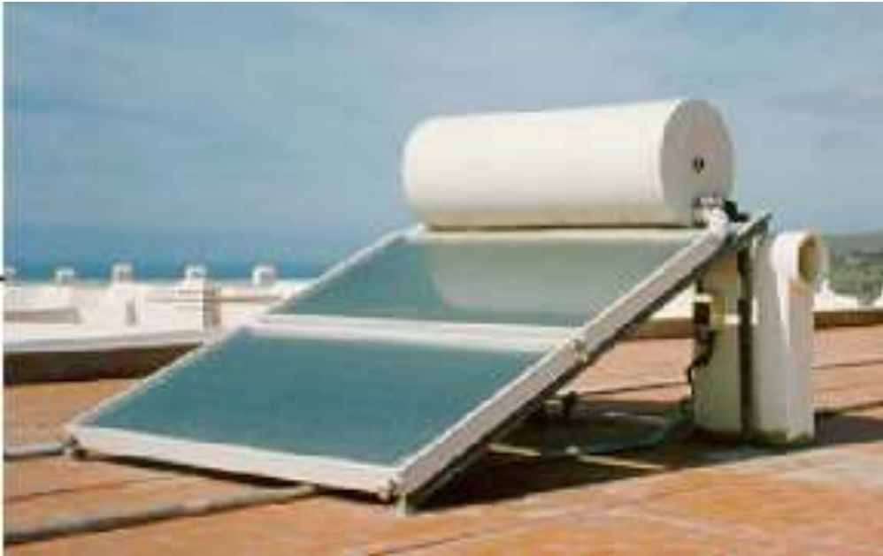
Figura 1.2. Colector solar de placa plana (Fuente: Bértiz L. y M. Álvarez, 2008)
