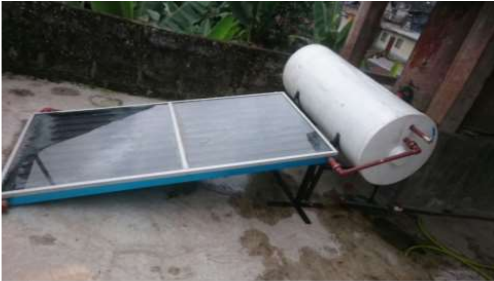
Figura 3.4. Colector seleccionado para el calentamiento de agua caliente sanitaria en viviendas unifamiliares (fuente: energos.com)
