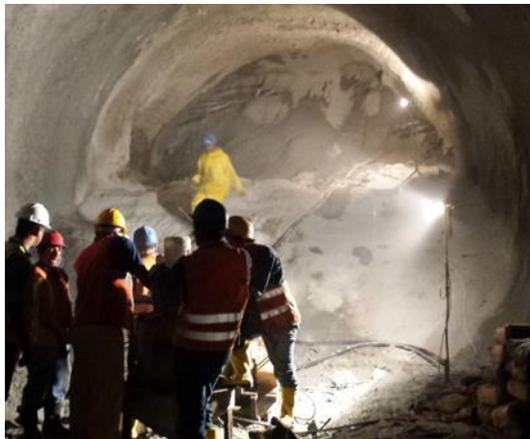
La imagen anterior muestra un derrumbe suscitado en el frente del túnel y como a medida que se avanza en las perforaciones y excavación, pueden cambiar las condiciones mecánicas y geológicas de la roca a pesar de realizar estudios previos, por tanto no se puede descartar el riesgo más solo minimizarlo.
