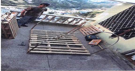
Anexo 1 Construcción de invernadero
